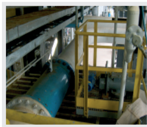
Fig. 5 - Esempi di V-Cone flangiato direttamente su una curva della tubazione per piattaforma offshore e in una unità di gassificazione
