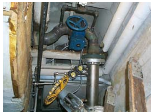
Esempio di V-Cone® installato
