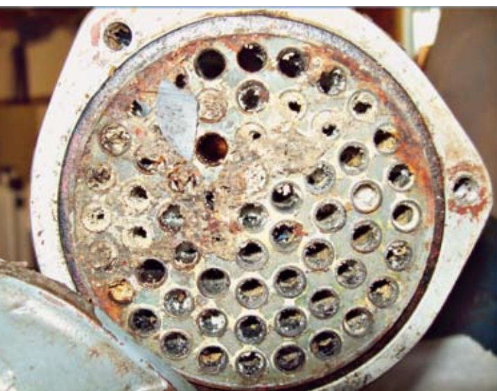
2 - Lo scambiatore di calore in manutenzione
